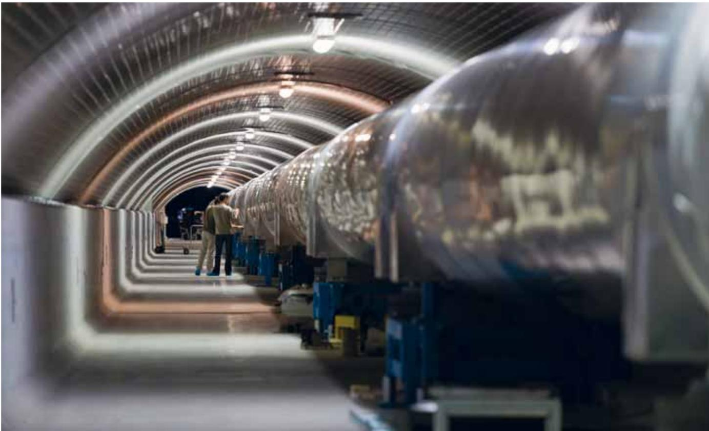
Intérieur du bras ouest de 3 km dans lequel circule l'un des deux faisceaux du laser infrarouge de l'interféromètre Virgo à Cascina, près de Pise. Ce détecteur capable de mesurer les ondes gravitationnelles, infimes déformations de l'espace-temps, est issu d'une collaboration internationale.
